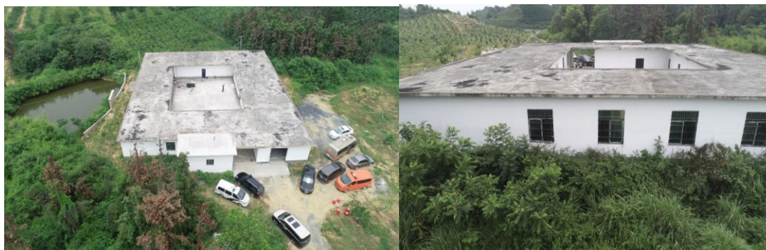
图 1.5、1.6 建筑东西两侧外墙门窗洞口无烟熏痕迹
