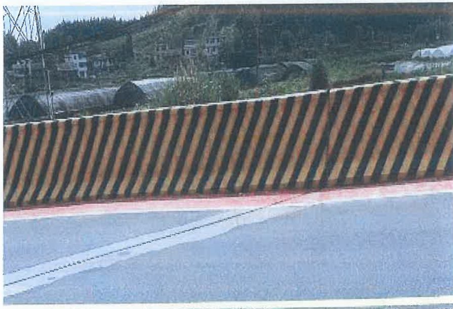
照片 5-7 防撞墙完好
