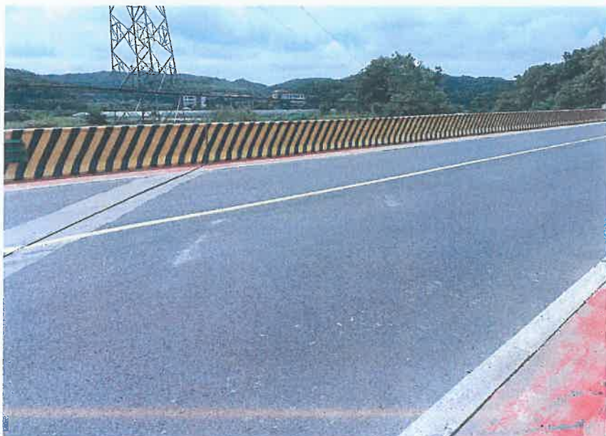
照片 5-6 桥面沥青铺装完好
