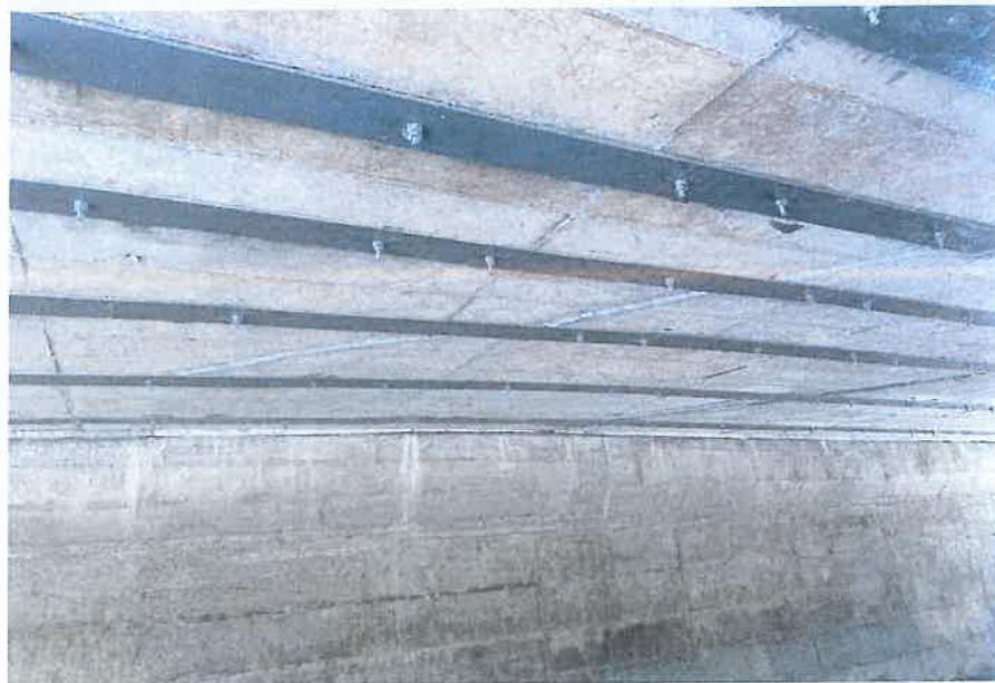
照片 5-1 加固后的现浇空心板梁
