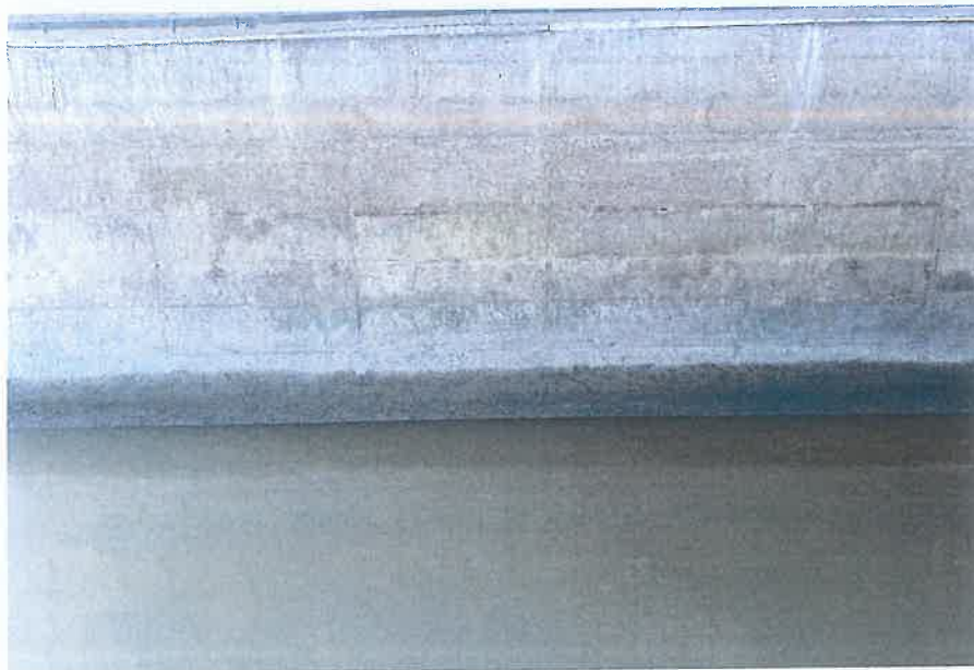
照片 5-3 墩台基础完好
