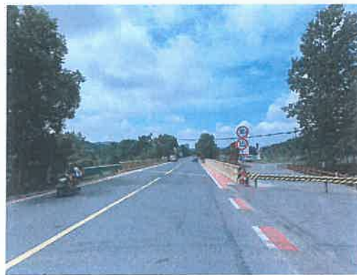
照片 1-2 桥梁正面照
