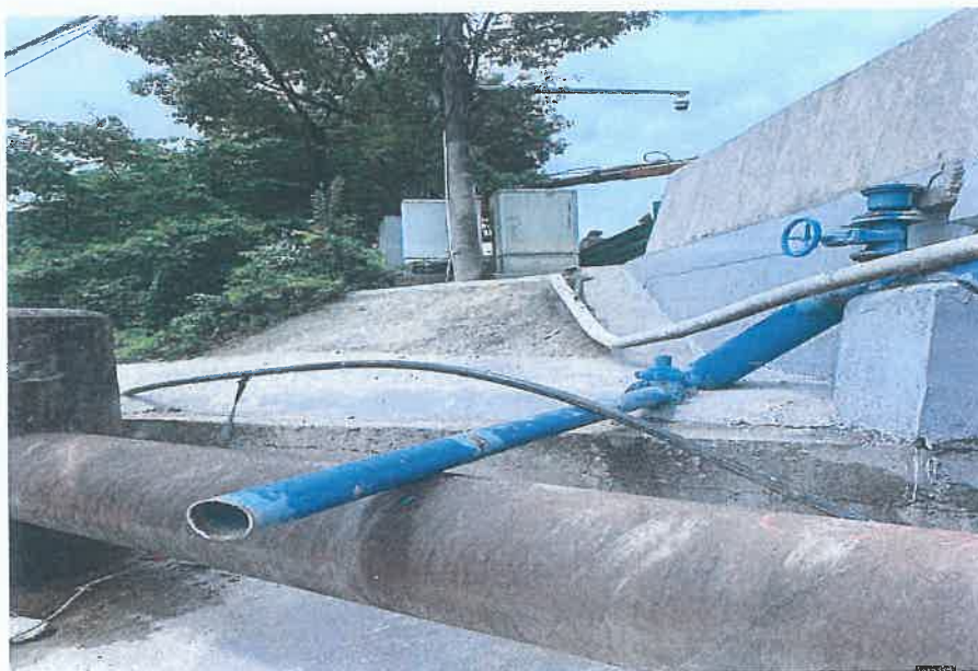
照片 5-4 锥（护）坡完好
