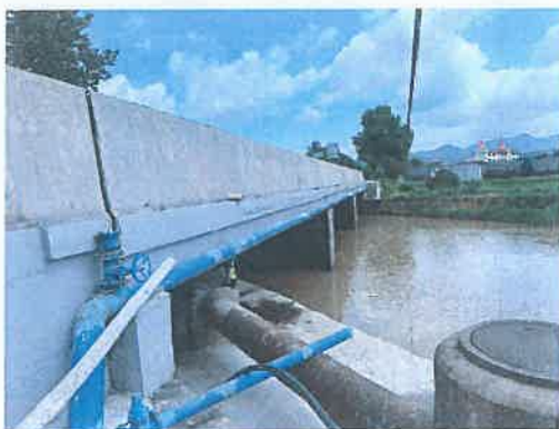
照片 1-1 桥梁立面照
